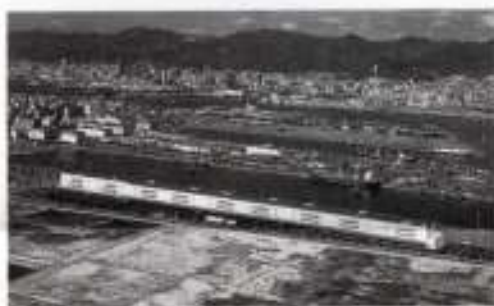
神戸国際物流センター(21世紀を見据えた高度物流センター)
