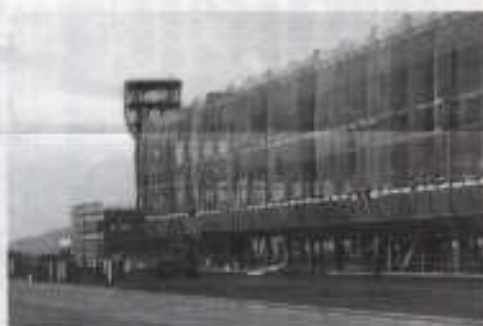
建設中の旅客ターミナル (平成17年1月末)
