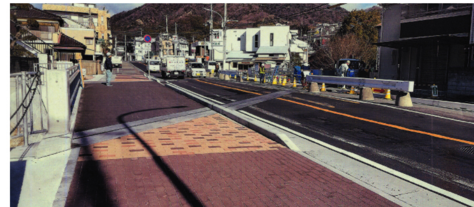
写真:2019.1.16明神橋架替工事が終了
